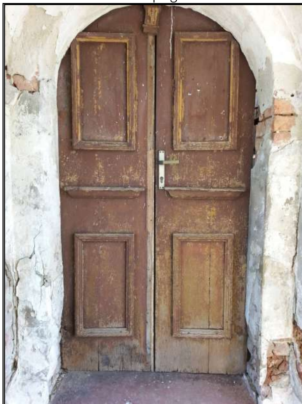
ulazna vrata: pogled izvana
